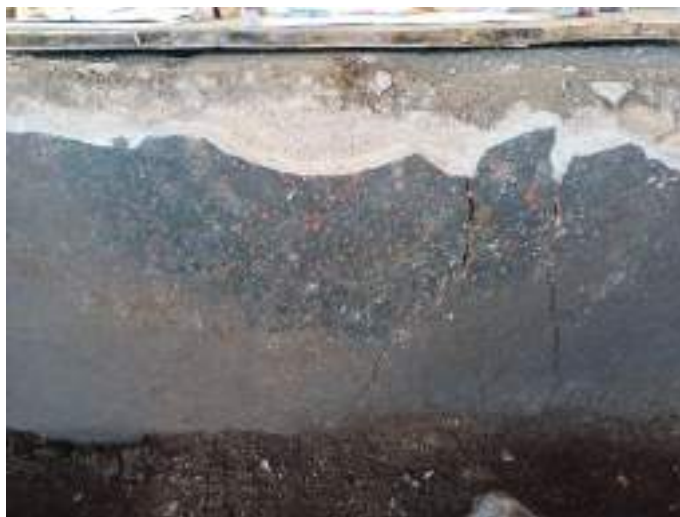
Zoccolo "spruzzato" rinvenuto in situ, in fase di consolidamento.
