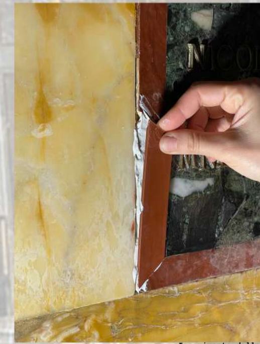
Inserimento delle fasce di reintegrazione
