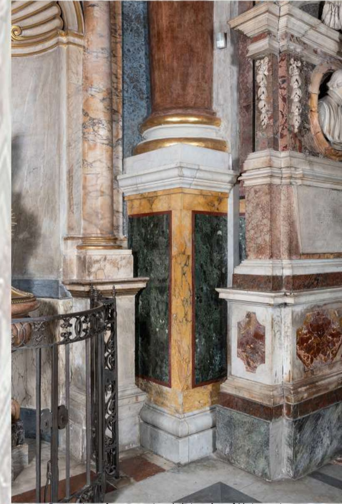
Basamento colonna navata sinistra dopo l'intervento
