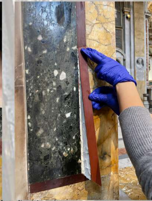
Inserimento delle fasce di reintegrazione
