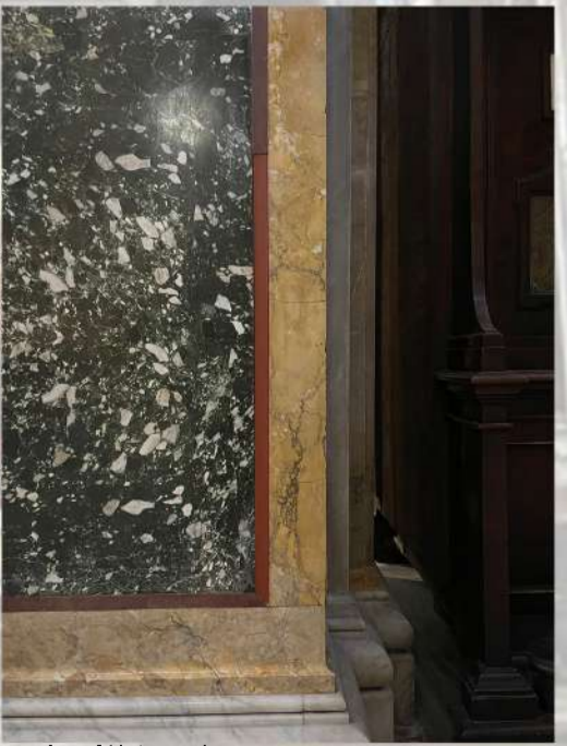
Particolare della mancanza prima e dopo l'integrazione
