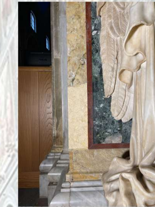
Particolare dell'integrazione con marmo Giallo Egiziano prima del ritocco pittorico
