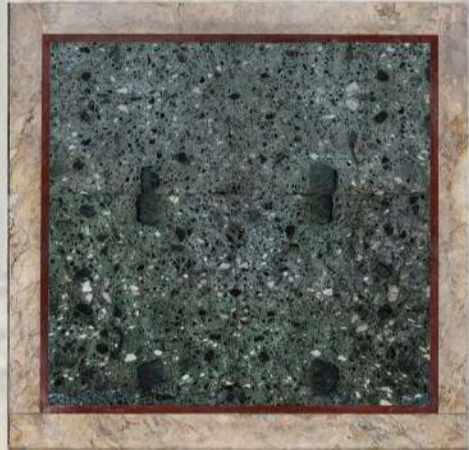
Particolare della foderia marmorea dopo l'intervento
