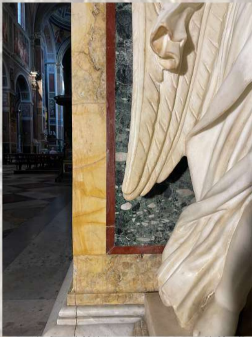
Particolare dell'integrazione con marmo Giallo di Siena prima del ritocco pittorico
