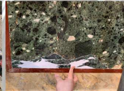
III FASE: inserimento dell'integrazione nella lacuna
