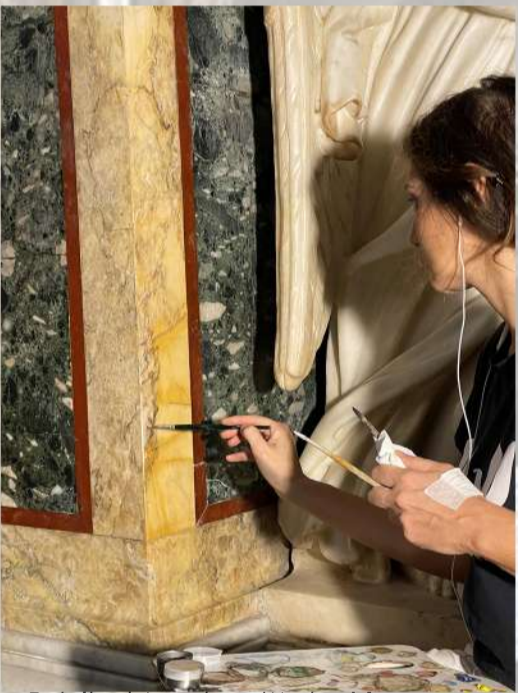
Fasi di reintegrazione pittorica del marmo con colori a vernice
