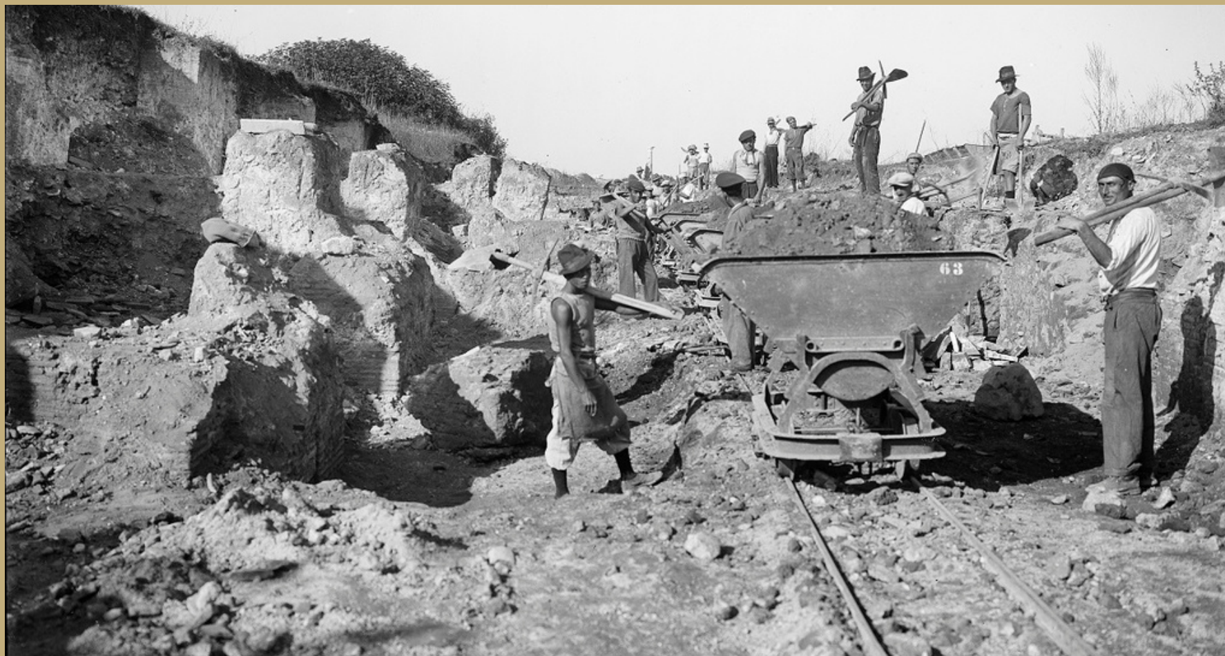
Scavi in corso sul Decumano Massimo, 1938
