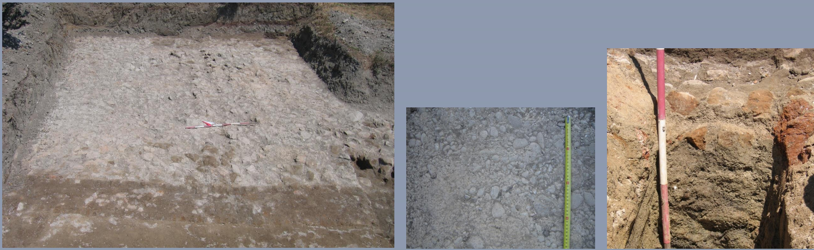
Foto 1: il piancito glareato con il muro di contenimento O. Foto 2: dettaglio del piancito. Foto 3: fondazione.
