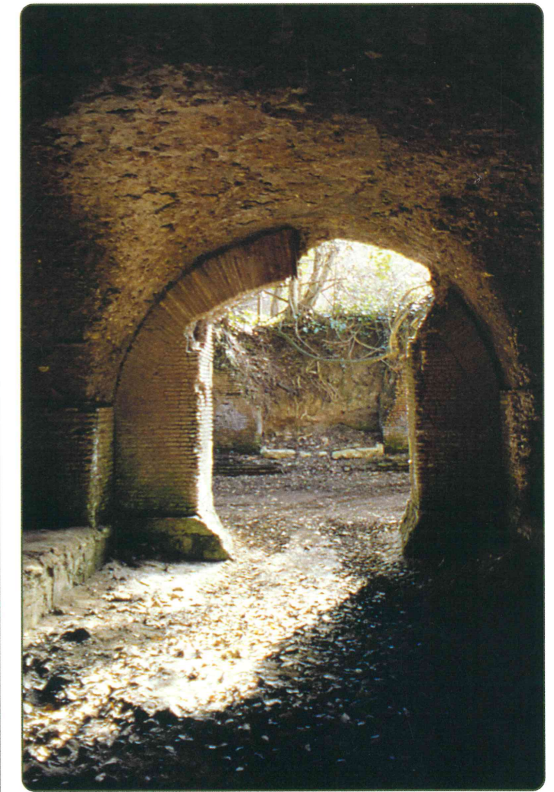
Interno di un vano dei magazzini
