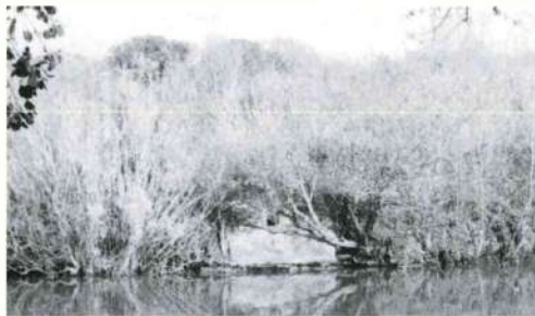
Pilone nord del ponte detto di Matidia.
