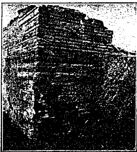
Fig. 126. - Costruzione in reticolato con legamenti in mattoni laterizi e di tufo, nella grande Casa signorile.
