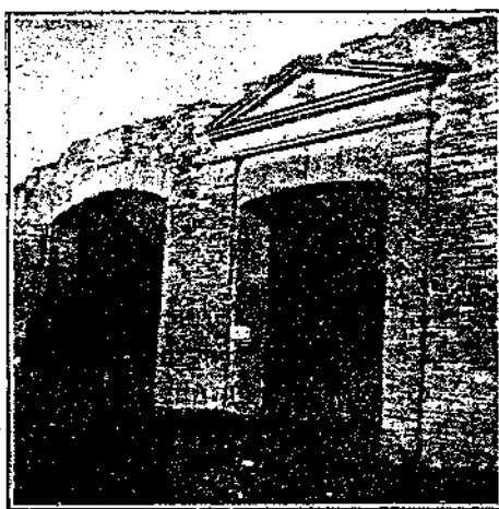
Fig. 75. - Ingresso all' Ufficio dei misuratori.
